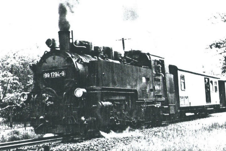
Lok der Betriebsgattung K 57.9, Baureihe 99, Spurweite 750 mm
